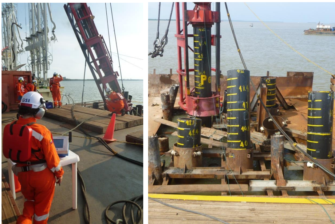
Figura 1. Vistas generales del monitoreo de hinca y del desarrollo de una prueba de carga PDA
