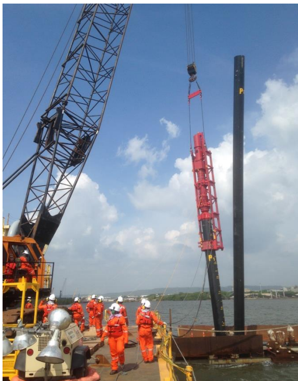
Figura 2. Imagen y esquema del montaje de una prueba dinámica a pilote pre-excavado
